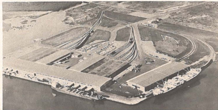
KEEFE SEAWAY TERMINAL
